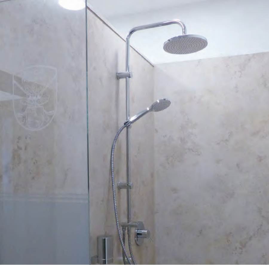
Die neuen Armaturen: Überkopf-Regendusche plus abnehmbare Handbrause
